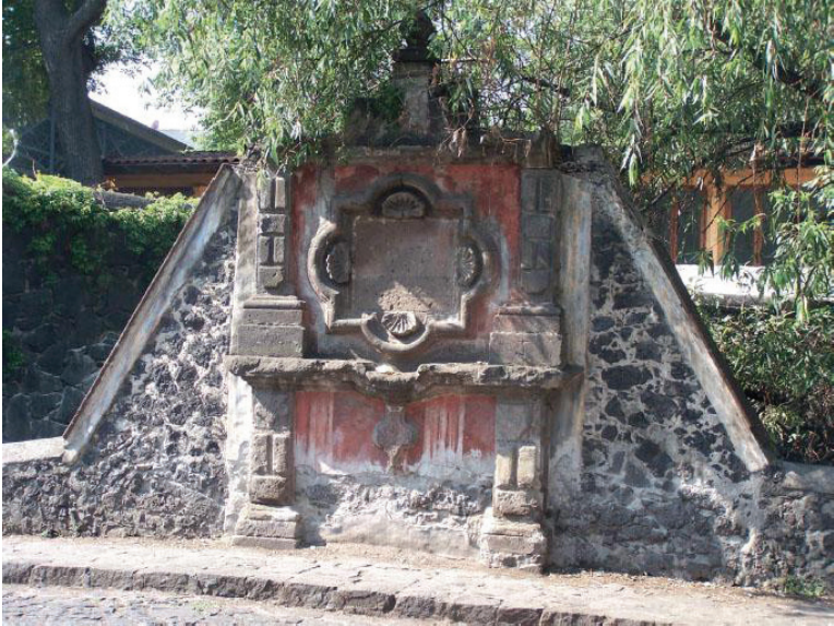
Cartela en el pretil sur del puente de San Antonio de Panzacola. (Foto de autor: julio 2013)
